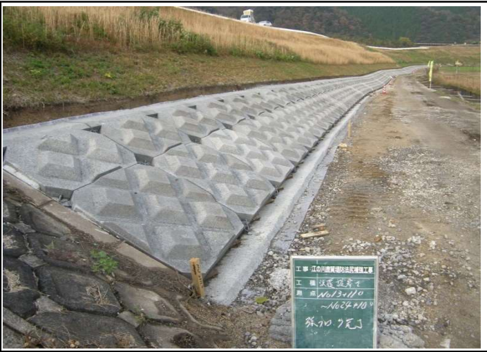
ブロック設置完了
