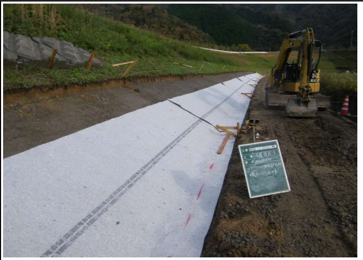
吸出防止設置完了
