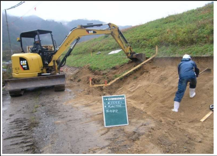
法面成形状況
