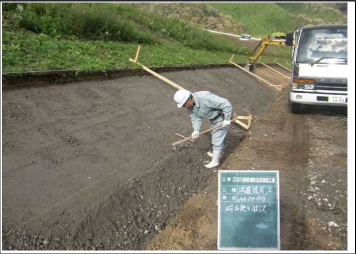
裏込碎石設置状況
