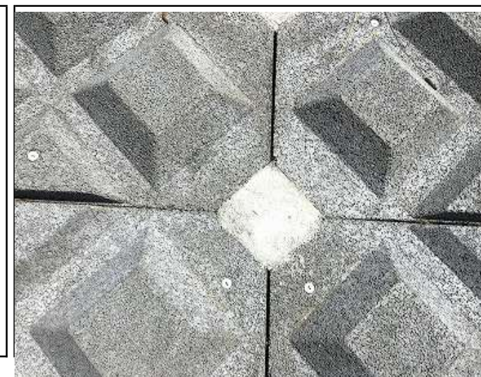
連結部処理(コンクリート)
