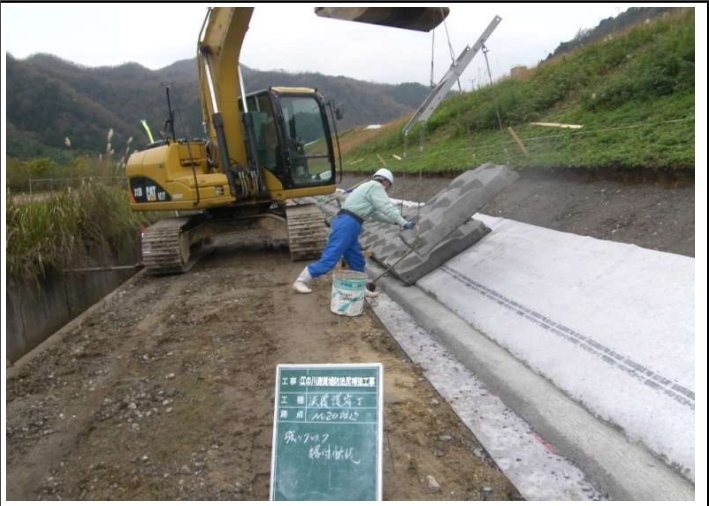
ブロック設置状況
