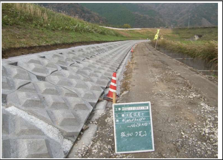
ブロック設置完了
