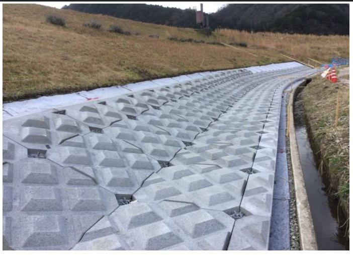
標準ブロック設置完了
