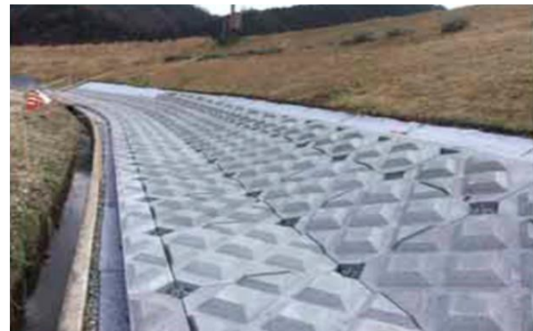
写真-1 テトラック法尻ブロック施工例
