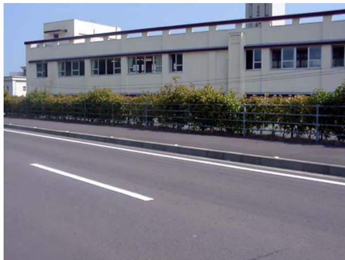
吸音歩車道境界ブロック施工事例
