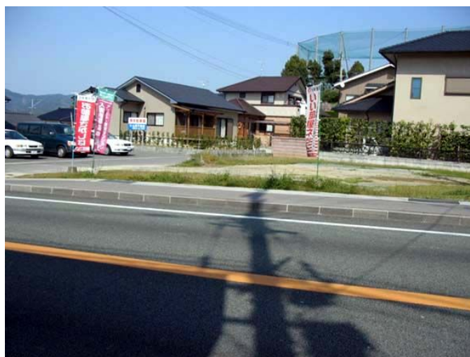
吸音歩車道境界ブロック施工事例
