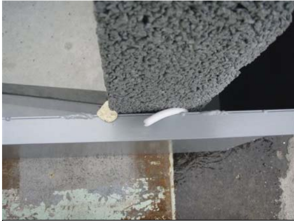
左：シリコンパテ、右：バックアップ材による止水状況
