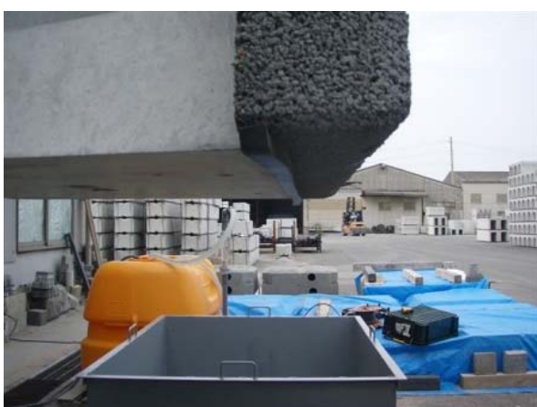
底部水膨張性パッキンにて止水
